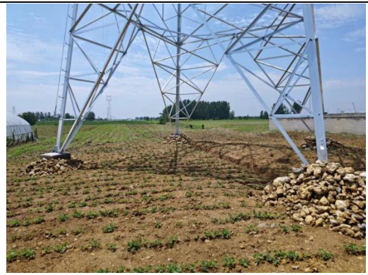
塔基周围生态恢复措施
