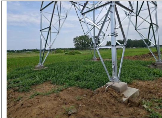
塔基周围生态恢复措施
