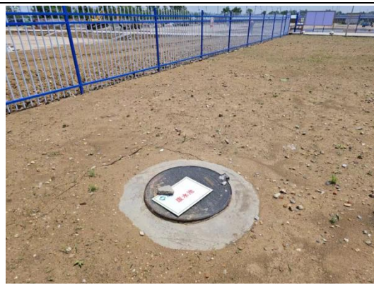
事故废水池（地下 500 方）
