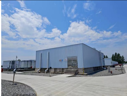
站内地埋硬化及砂石化
